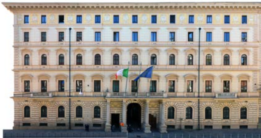
Fig. 1 Palazzo Baracchini (foto-raddrizzamento). Fonte: ENEA
