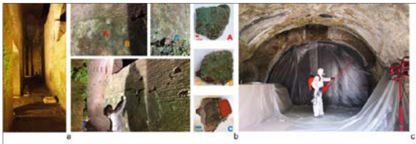
Fig. 3 Domus Aurea, Parco Archeologico del Colosseo, Roma. a) Le pareti e le volte mostrano una significativa colonizzazione di film biodeteriogeni complessi b) 2017 - interventi iniziali su frammenti di reperti affrescati applicati in maniera reversibile alle pareti e trattati in laboratorio c) 2021 - applicazione mediante lancia telescopica di una miscela sperimentale a base di estratti vegetali in una sala della Domus Aurea.
