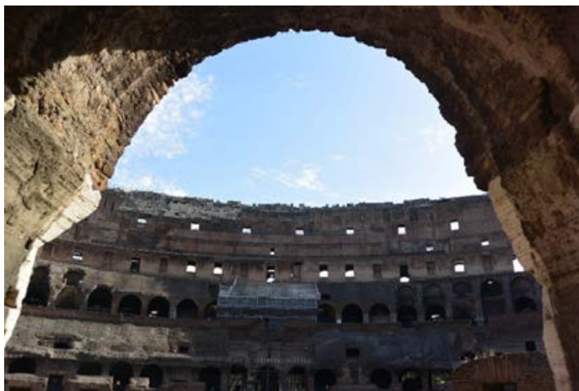
Fig. 1 La parete nord vista dall'interno
