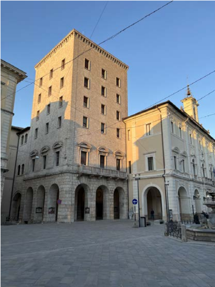
Fig. 1 La Torre Civica del Comune di Rieti (Sistema di monitoraggio dinamico di UNIRM1-DISG)
