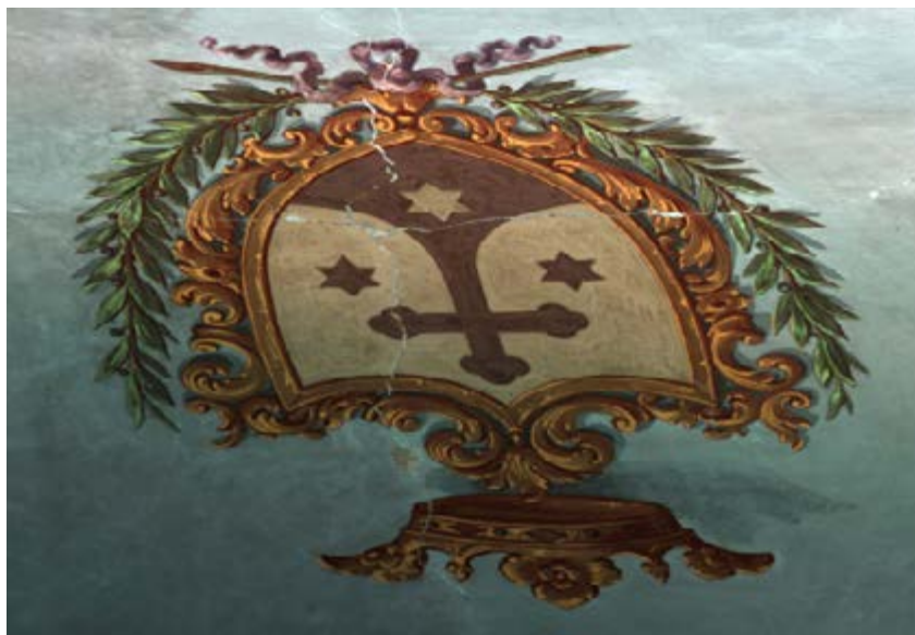
Fig. 1 Dettaglio del modello 3D a colori della Sala delle Vendite ottenuto con RGB-ITR. L'alta risoluzione raggiunta permette di leggere sia le scritte presenti nella sala come quelle della targa situata sopra la porta di ingresso e sia di rilevare la presenza di crepe sulle pareti e sul soffitto della sala come mostrato in figura dove sono ben visibili le crepe su uno stemma presente sul soffitto.
