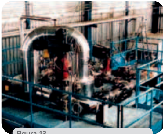
Figura 13 Prove del sistema automatico di depressurizzazione del reattore AP600 (Westinghouse). Vista d'insieme in una fase della campagna sperimentale Fonte: ENEA
