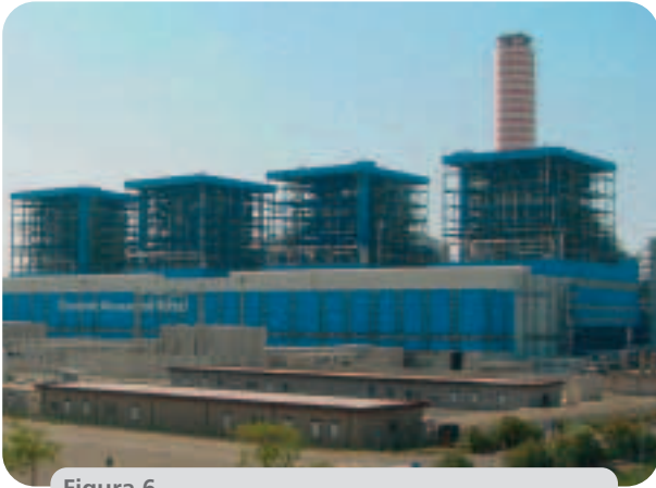
Figura 6 Opere civili realizzate per la centrale di Montalto di Castro Fonte: SOGIN
