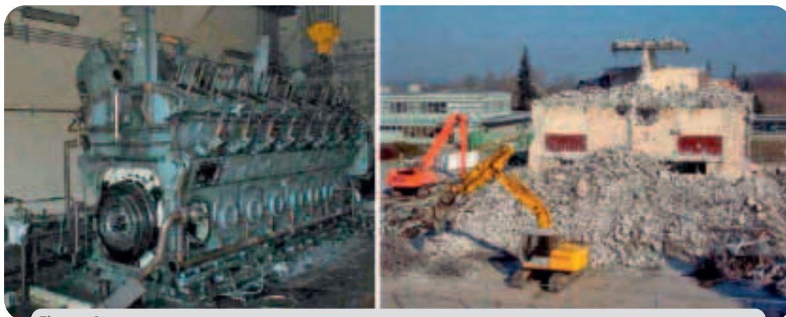
Figura 4 Smantellamento di un componente e demolizione dell'edificio Fonte: immagine tratta da Internet
