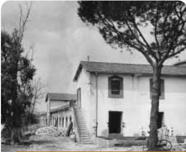
Figure 1-2 Fasi di costruzione del Centro della Casaccia Fonte: archivio ENEA
