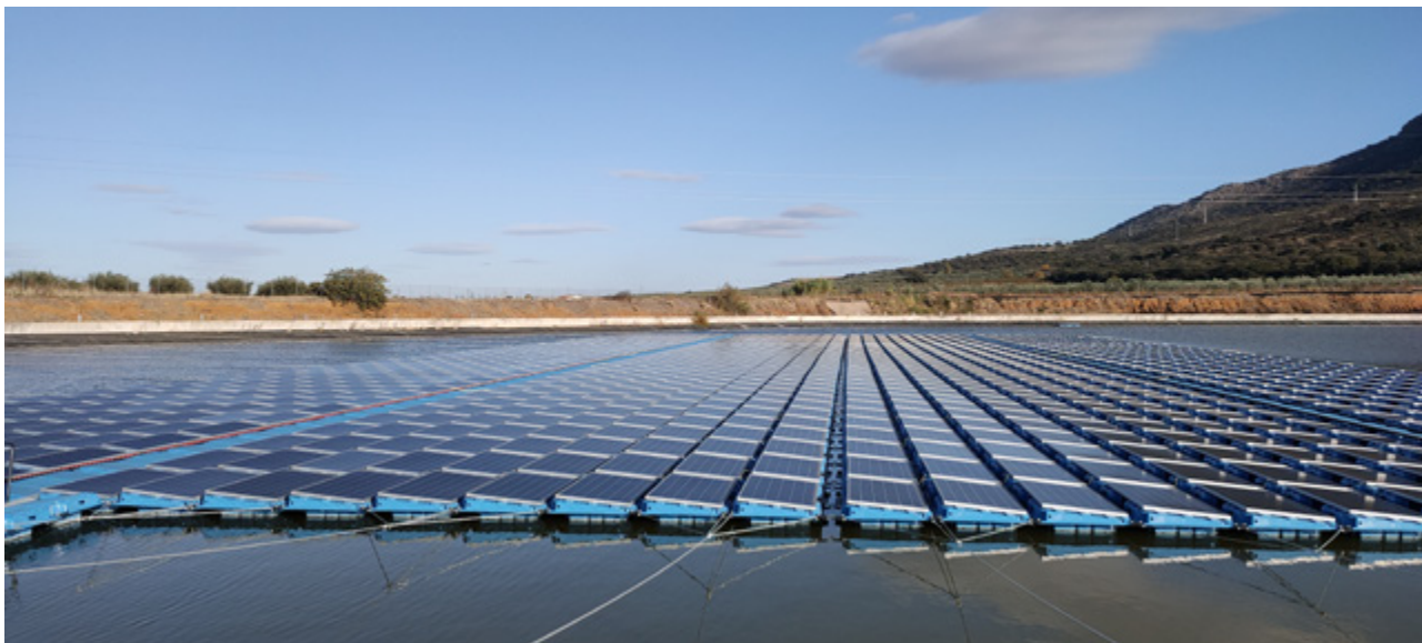
Impianto fotovoltaico flottante su bacino idrico (Comunità irrigua di Merida, Extremadura, Spagna).
