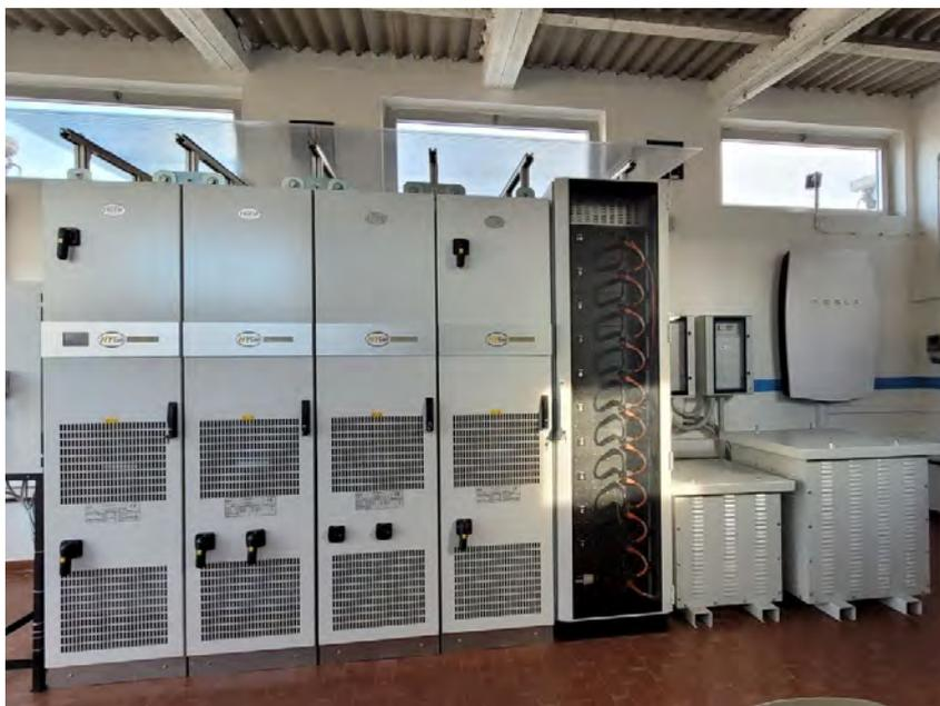
Foto 1: Sistema di conversione e gestione della potenza (FRIEM) e Sistema di accumulo (FAAM)
