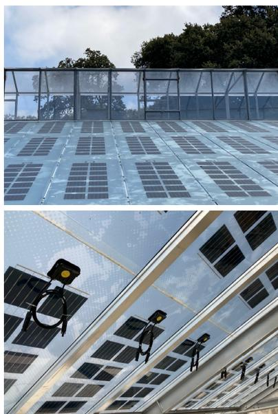
Figura 3: Dimostratore agrivoltaico in pieno campo, con impiego di vetri fotovoltaici progettati da ENEA per una piena funzionalità rispetto alla trasmissione luminosa all'interno della serra ed all'integrazione con il contesto di pregio. Presso l'Orto Botanico realizzato presso il giardino della Reggia Borbonica di Portici, sede del Museo delle Scienze Agrarie (MUSA) e della Facoltà di Agraria dell'Università degli Studi di Napoli Federico II. Vetri fotovoltaici realizzati da SunAge.
