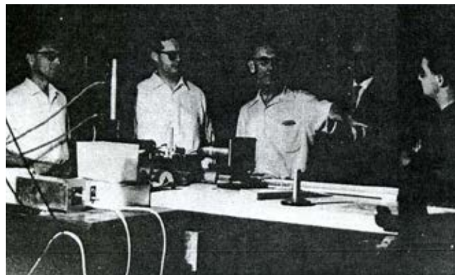
FIGURA 1 Ugo Ascoli-Bartoli, Alberto De Angelis, Franco Rasetti, Antonio Bolle e Sergio Martellucci (da sinistra a destra) discutono il principio di funzionamento di uno spettrografo a reticolo ad alta risoluzione costruito per la misura della temperatura del plasma ("Laboratorio Gas Ionizzati" al piano sotterraneo dell'Istituto di Fisica "Guglielmo Marconi" di Roma, 1959)
