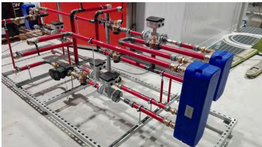
Fig. 4 Sottostazione bidirezionale di scambio termico
