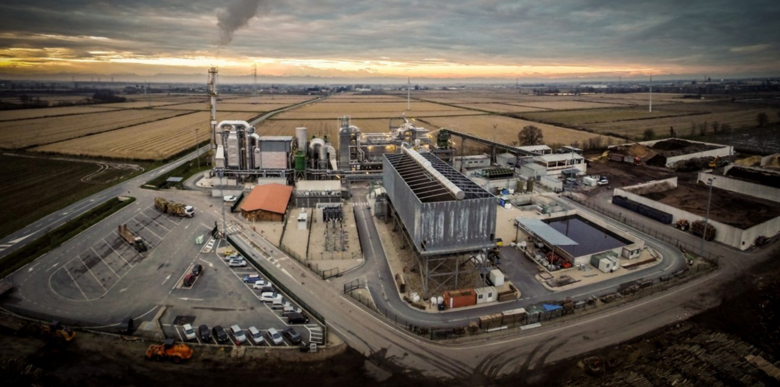
Impianto a biomasse di Olevano di Lomellina (Pavia). La centrale elettrica è alimentata da cippato di pioppo
