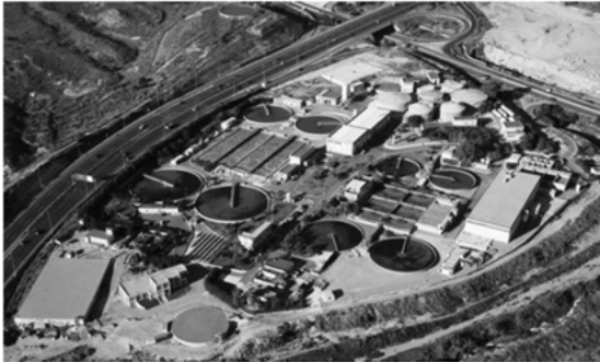
Figura 2 - Impianto di trattamento delle acque reflue di Rincón de León (Alicante, Spagna) [5]
