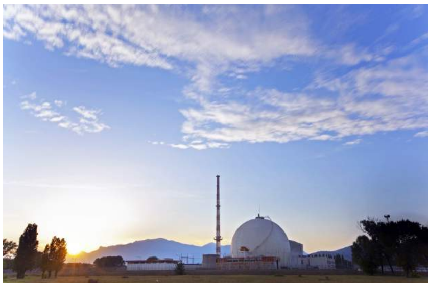
Fig. 1 La centrale nucleare del Garigliano prima della demolizione del camino
