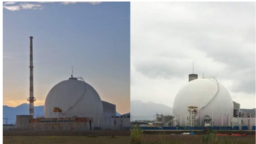
Fig. 2 Lo skyline della centrale del Garigliano prima e dopo lo smantellamento del camino
