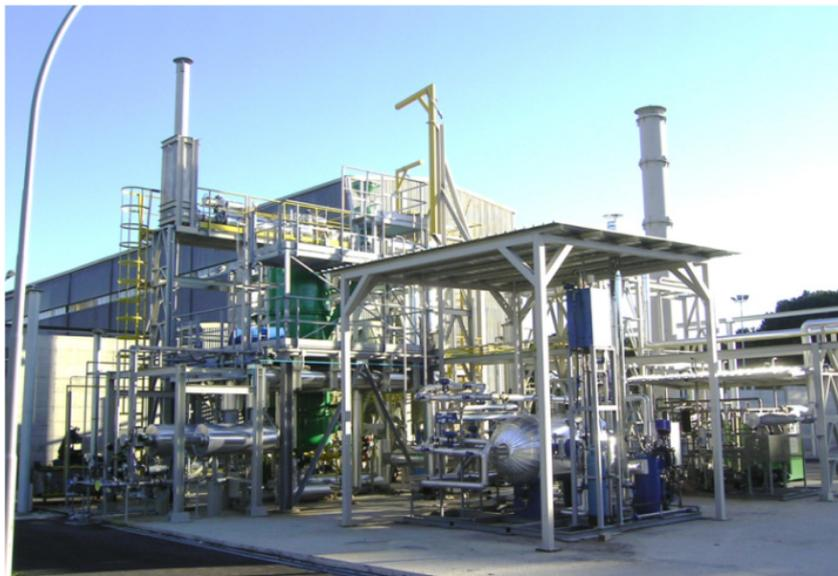
Fig. 2 Infrastruttura di Ricerca Europea ZECOMIX per lo studio del processo di cattura della CO<sub>2</sub> attraverso un processo di carbonatazione
