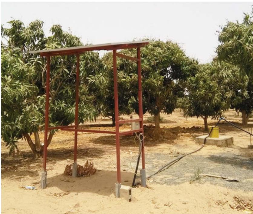
Fig. 2 Pompa solare (200W) accoppiata a due pannelli fotovoltaici (250 W x 2 di picco), nel campo di Ndokoura, Yène (Senegal)
