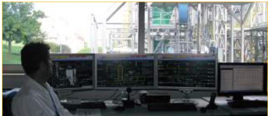
**FIGURA 2** L'impianto Zecomix presso il Centro ENEA Casaccia consente di effettuare test sulle diverse fasi di una nuova tecnologia per la produzione di gas ricco di idrogeno ed energia elettrica da carbone con contemporanea cattura della CO<sub>2</sub>
