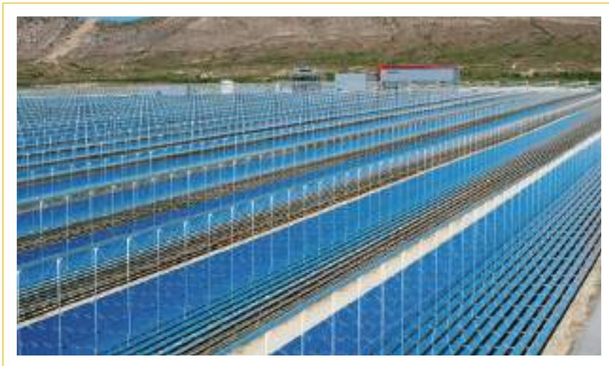
**FIGURA 4** Impianto a collettori lineari Fresnel (Novatec)
