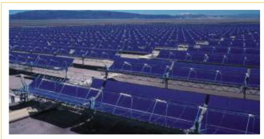
**FIGURA 2** Impianto commerciale a collettori parabolici lineari (SEGS – USA)
